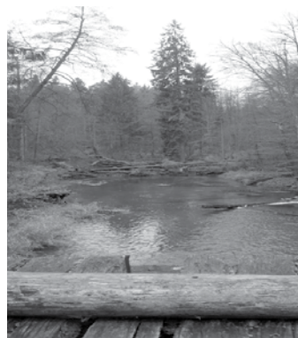
Мост на реке Чёрной в Роминтской пуце
