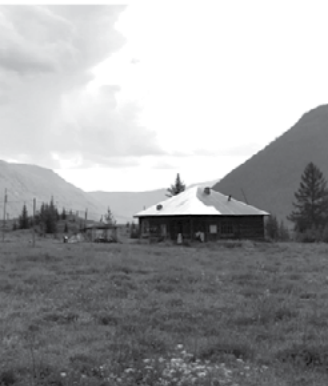
Дом начальника заставы Язула — ныне жилой дом кордона Алтайского заповедника
