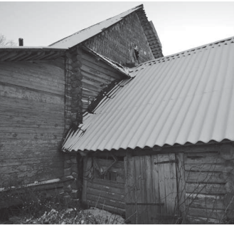
Рисунок 13. Переход жилого дома и двора. Виден фасад, зашитый дранкой
