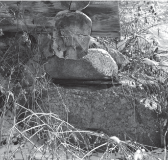
Рисунок 14. Фундамент – гранитные валуны под углами сруба, д. Голузино, 2017
